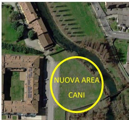
IN VIA MADRE TERESA DI CALCUTTA ACCANTO AL COMPLESSO RESIDENZIALE "LE CORTI"
