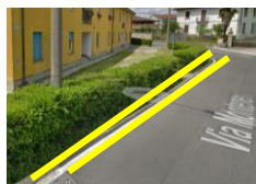
VIA MONTENERO VICINO AL PONTE CARRABILE: MESSA IN SICUREZZA DEL TRATTO SCOSCESO
